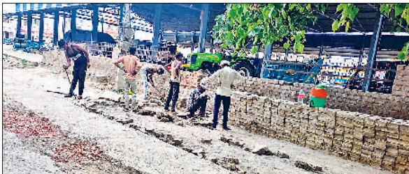
उद्याना। कपास मंडी के साथ लगते सड़क निर्माण का चल रहा कार्य।
